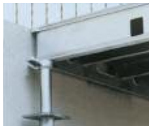
Längs der Wand sorgt das Randlager für lückenlosen Anschluss.
